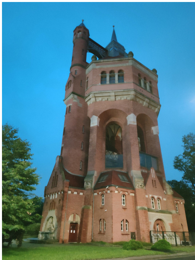
Zrewitalizowana wieża wodna we Wrocławiu
