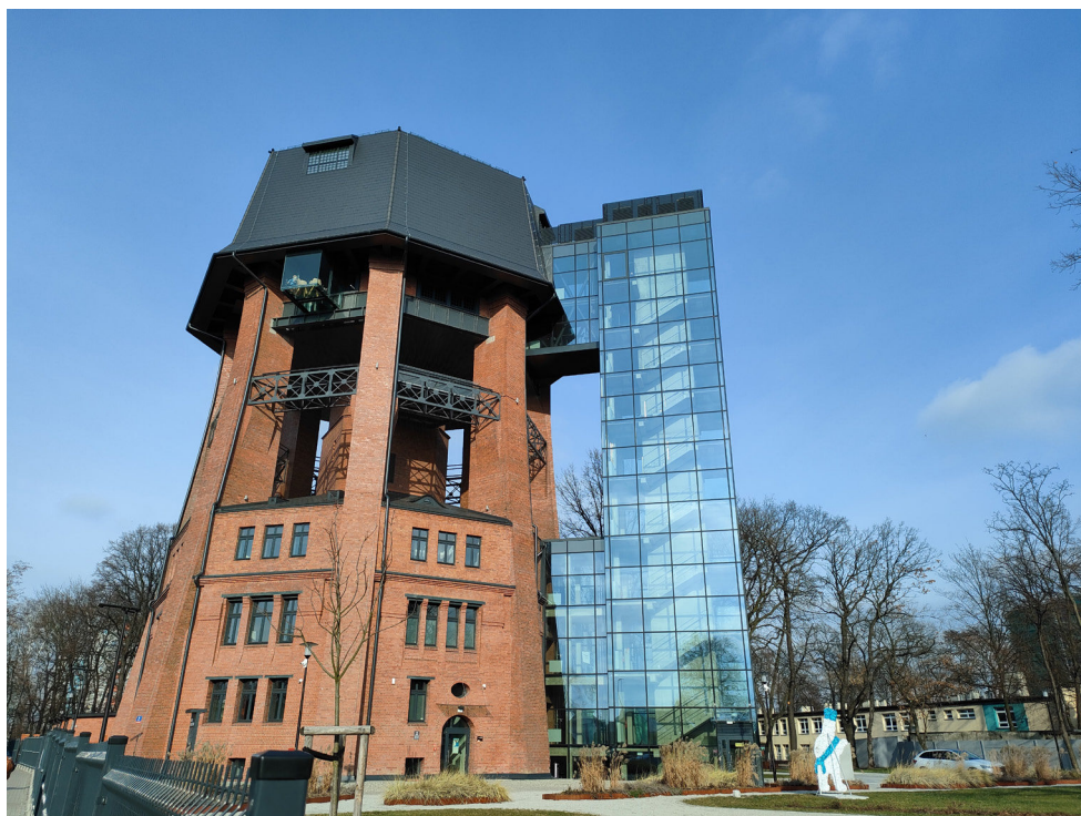
Zrewitalizowana wieża wodna w Zabrzu
